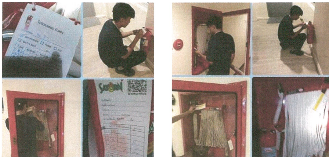
รูปภาพที่ 2.16 การตรวจสอบการทำงานของระบบป้องกันอัคคีภัย
